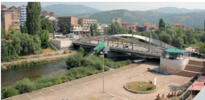
Die gesperrte Brücke über dem Ibar
