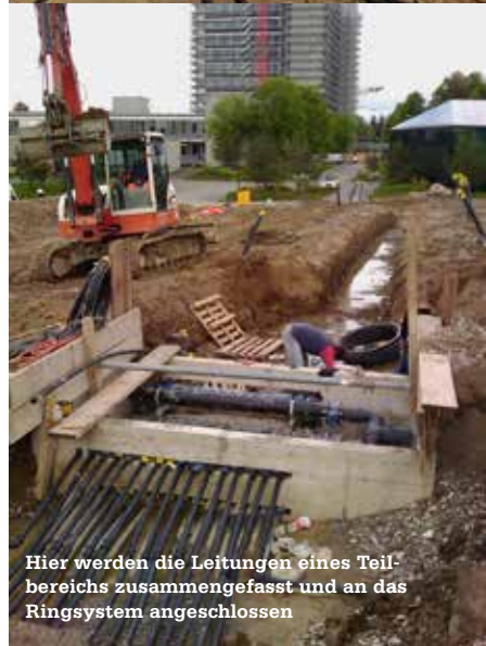
Verlegung der Erdsonden und Leitungen hinter dem HCI
